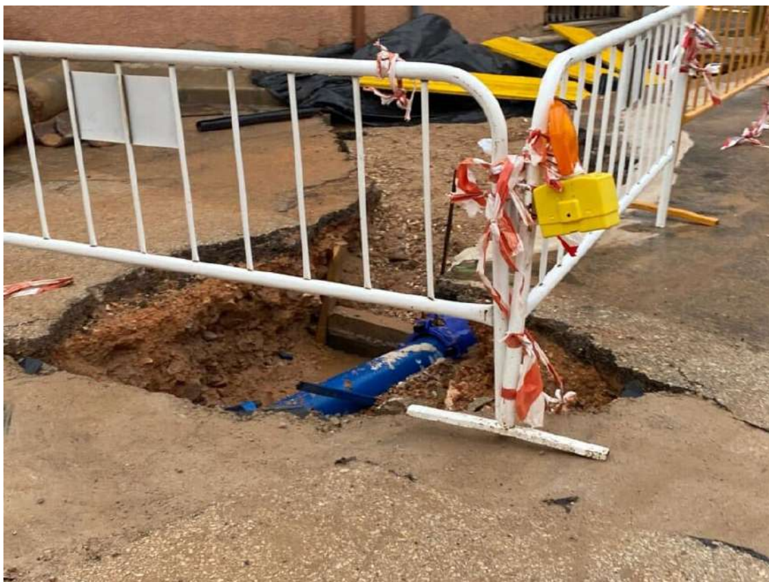
Obra en el suministro de agua de La Solana
