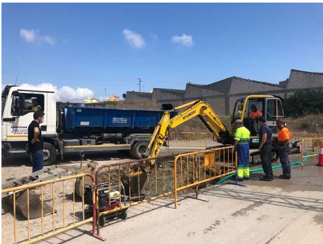
Emalgesa reparando una avería en Algeciras.
