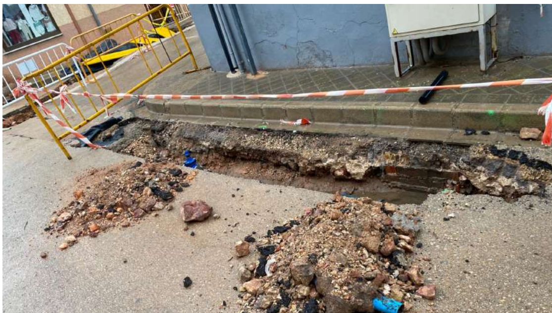
Obra en el suministro de agua de La Solana
