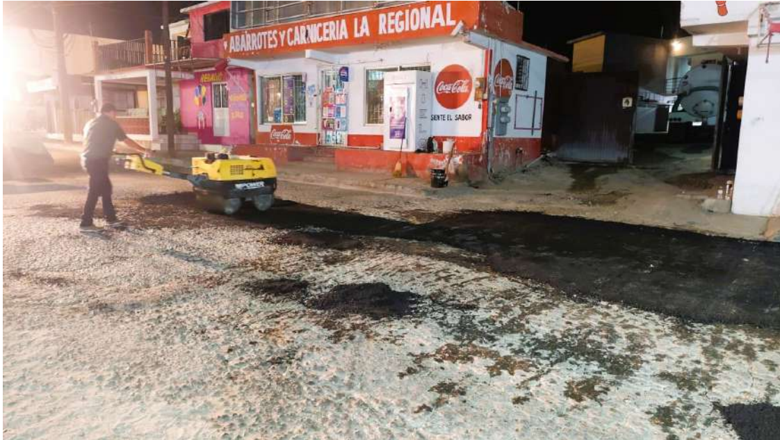
Con cuadrillas de Obras Públicas, Oficialía Mayor, Servicios Públicos y Oomsapas
